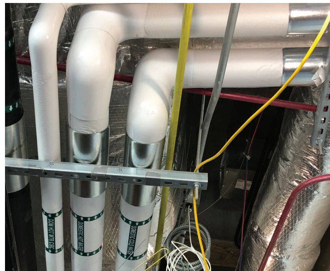
Isolation posée à l'aide de crochets à chape
